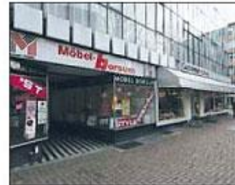
FAIRKAUF: Ins ehemalige Möbelhaus Borsum, gebaut mit groben Glasfronten in den 50er Jahren, zieht das erste Sozialkaufhaus ein.
